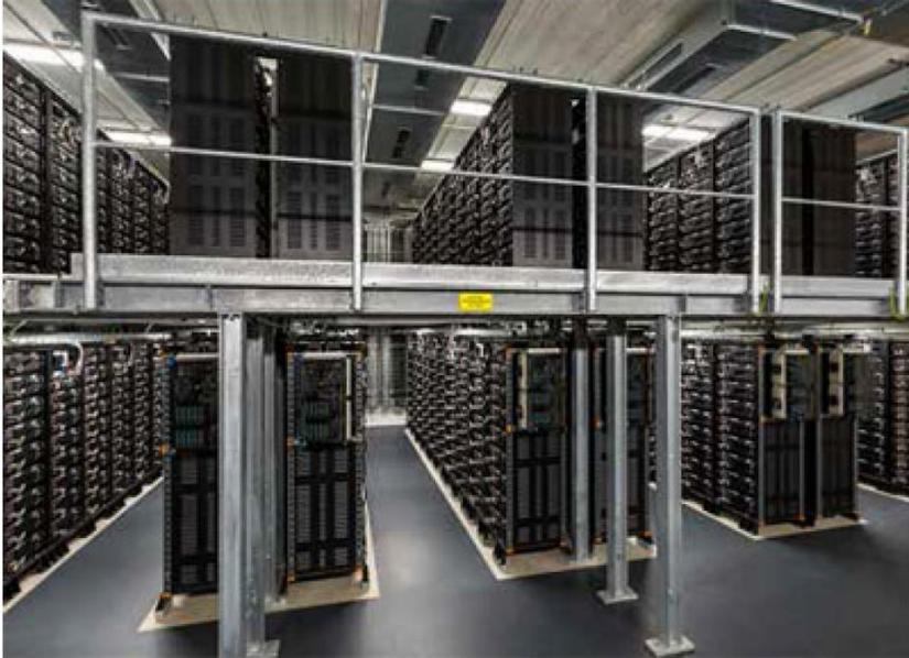
Über 25.000 Lithium-Ionen-Batterien stabilisieren in Schwerin die Netzfrequenz.
