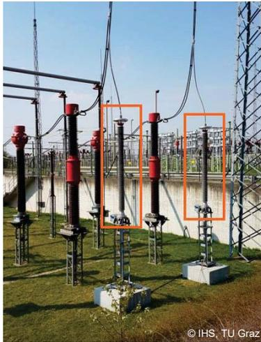
Installierte 400-kV-RC-Teiler (orange)
