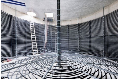
Viessmann/Isocal: Betonzisternen mit PE-Rohren
