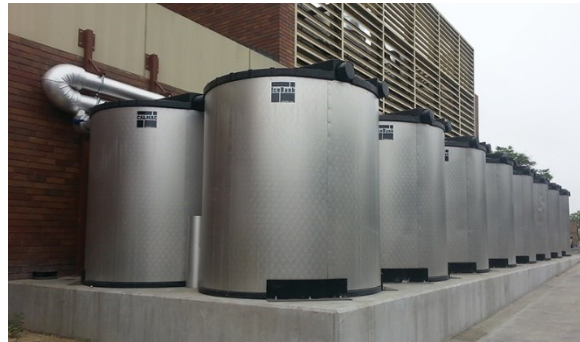
Calmac/Trane: Einfach zu Batterien verschaltbare Kunststofftanks
