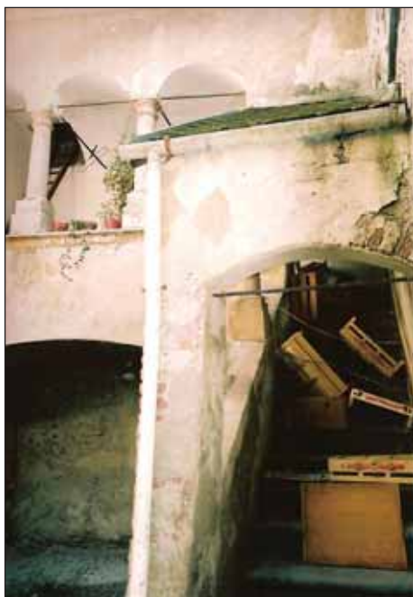
Foto 7: Hinterhof eines denkmalgeschützten Gebäudes
