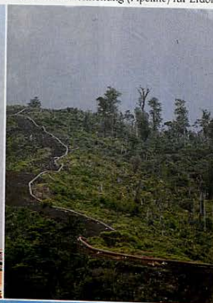
Abb. 84.2: Rohrleitung (Pipeline) für Erdöl
