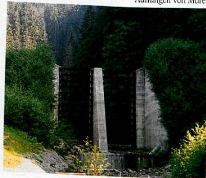
Abb. 74.4: Balkensperre zum Auffangen von Muren
