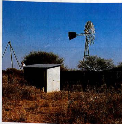
Abb. 52.2: „In diese Zisterne wird Grundwasser mit dem Windrad gepumpt – bei Windstille mit der Motorpumpe“.
