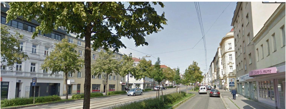
Was für eine Veränderung erkennen sie bei dem Gebäude am linken Bildrand ?
