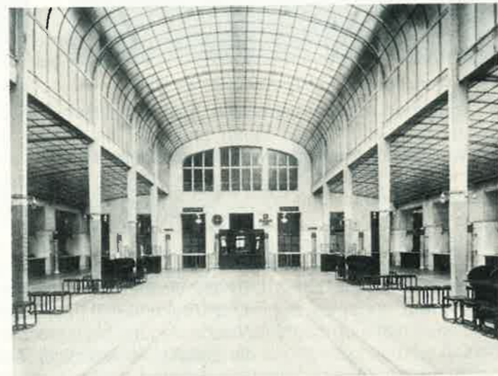
O. Wagner: Österr. Postsparkasse, Schalterhalle
