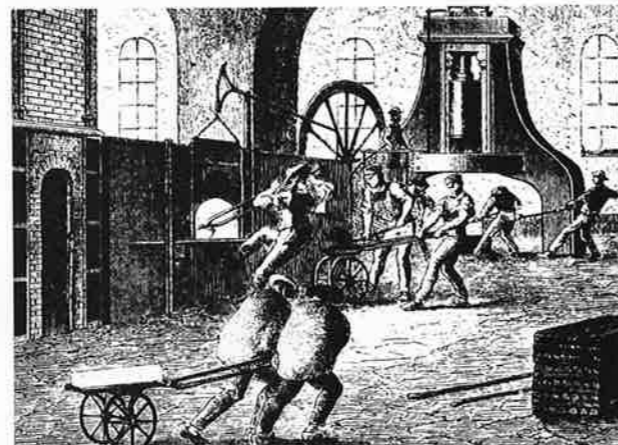
Dampfhammer in der Schmiede – die Mechanisierung der Arbeit
