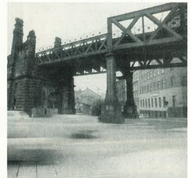
ehem. Stadtbahn, „Viadukt über die Zeile“ (Sechshauser Straße, Linke Wienzeile): Otto Wagner, 1897.
