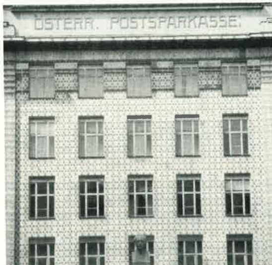
O. Wagner: Österr. Postsparkasse (1904–1906), Fassade
